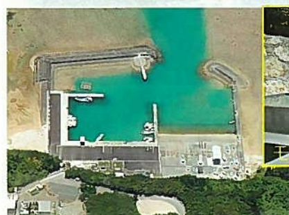
喜屋武漁港（第1種漁港） 生産拠点の整備
