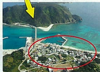
漁業集落環境整備事業で集落排水施設や集落道等が整備された。
