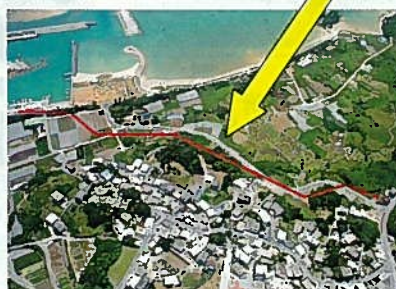
漁港関連道路整備事業で漁港と幹線道路を結ぶアクセス道路を整備し流通・輸送の合理化を図った。
